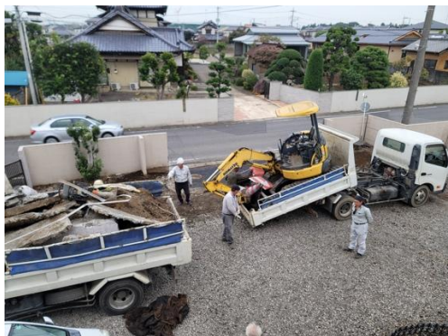
3. 敷地入口壁撤去作業
