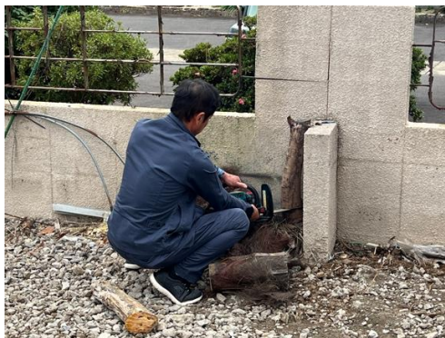
4. 樹木伐採作業中
